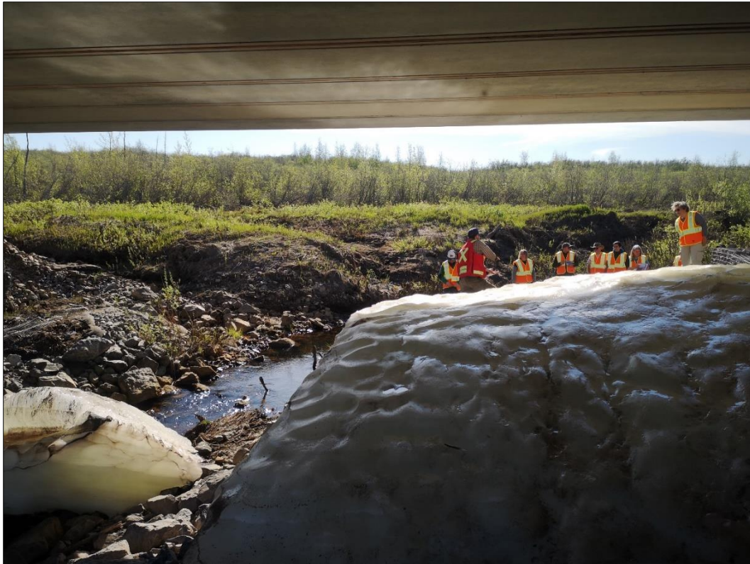
Lód wzrastający pod mostami na obszarze występowania permafrostu.
