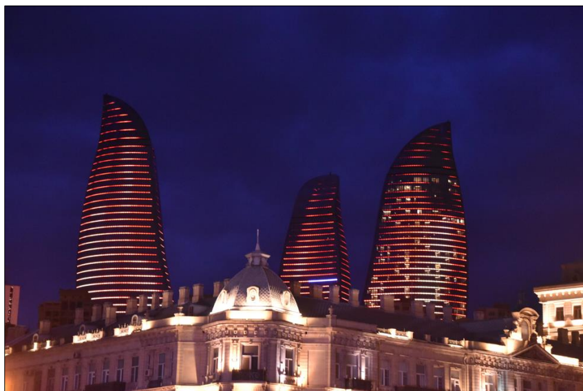
„Płonące Wieże” – symbol nowoczesnej architektury Baku.
